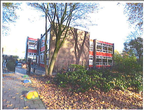
Foto 1: zuidzijde school, aanzicht naar het noorden
