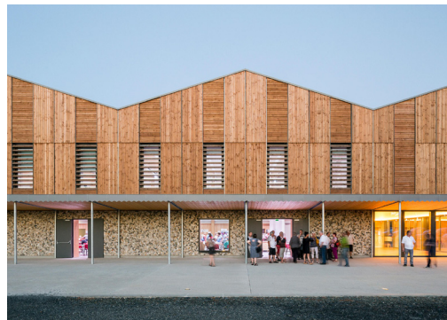
Herkenbare dakvorm en simpele materialisering Pratgraussals events hall, Albia PPA Architectures
