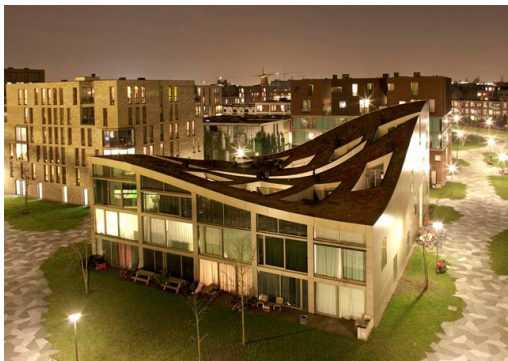
Herkenbare dakvorm in een herkenbaar volume Funen blok K, Amsterdam NL Architects
