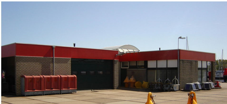
Afbeelding 2.2 het bestaande kantoorgebouw met werkplaats
