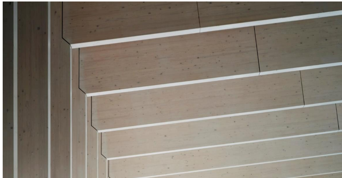
Gelamineerde houten spanten met whitewash
