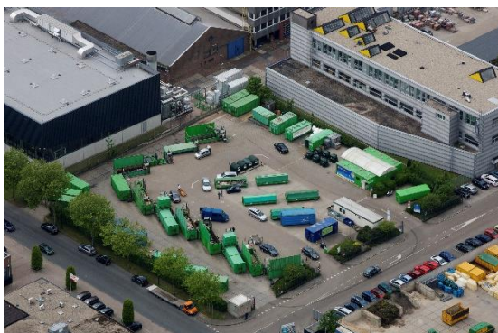
Scheidingsstation Huizen Ambachtsweg 13 1271 AL HUIZEN
