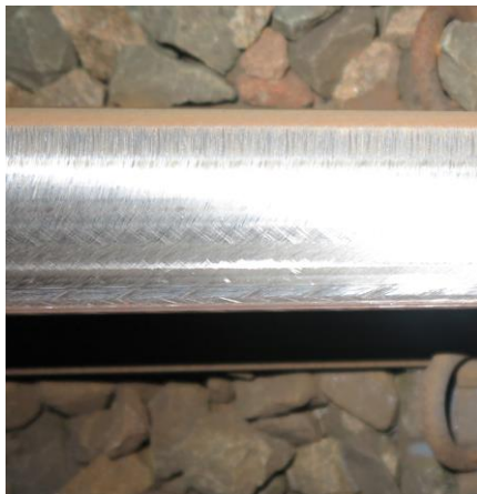
FIG 2: BEWERKT OPPERVLAKE MET TOEGESTANE LICHT VERKLEURING
