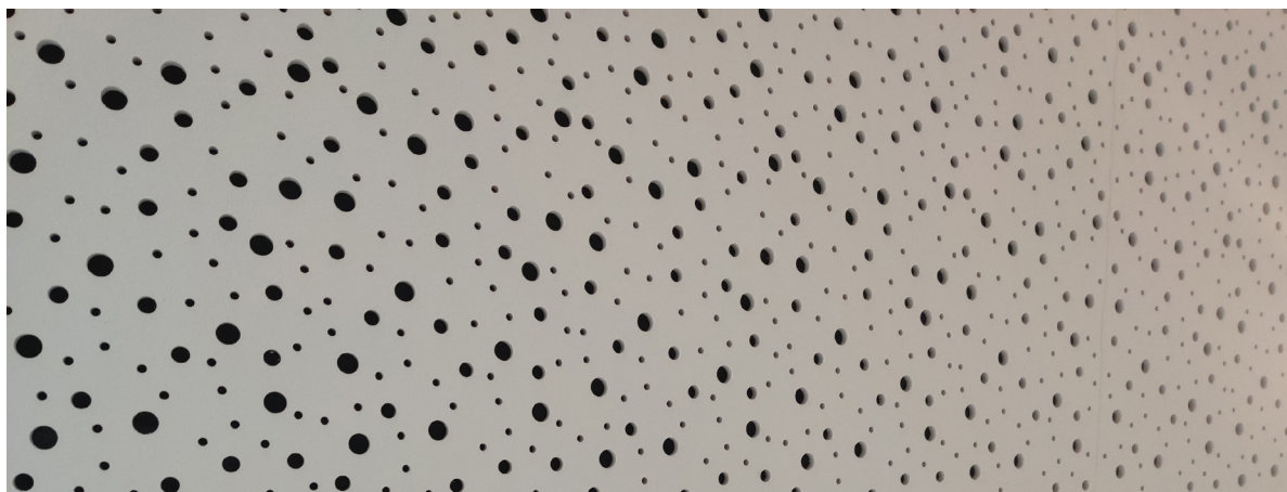
Het patroon van de perforaties voor het akoestische plafond
