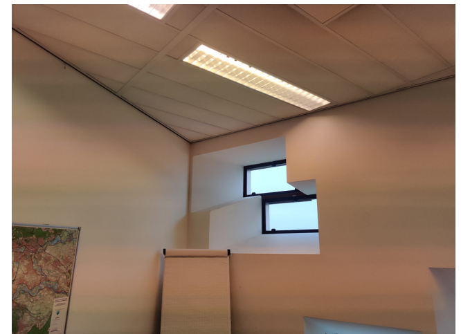
Huidige plafond- en wandafwerking
