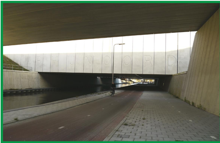
Lange zichtlijnen door het kunstwerk en buiten het kunstwerk naar de lucht maken de onderdoorgang overzichtelijk en ruim. RWS onderdoorgang bij tunneltracé A2 De Meern
