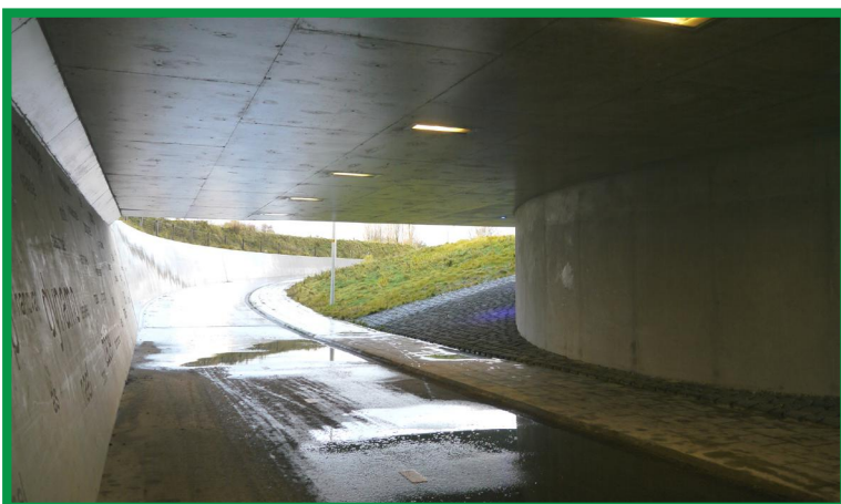
Door de ronde vormgeving van de oplegging worden 'blinde' hoeken voorkomen. RWS onderdoorgang N9 bij Schoorlham
