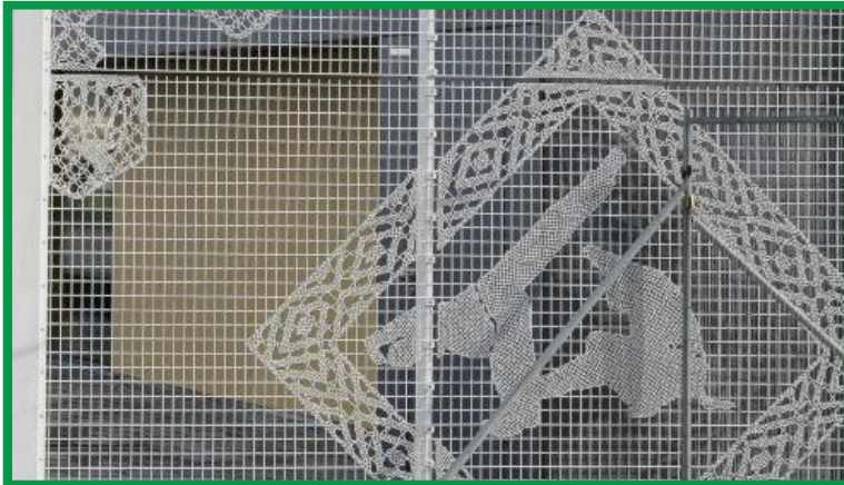
Drie meter hoog stalen hekwerk met geïntegreerde patronen. Referentie ontwerp Daf architecten / Demakersvan.
