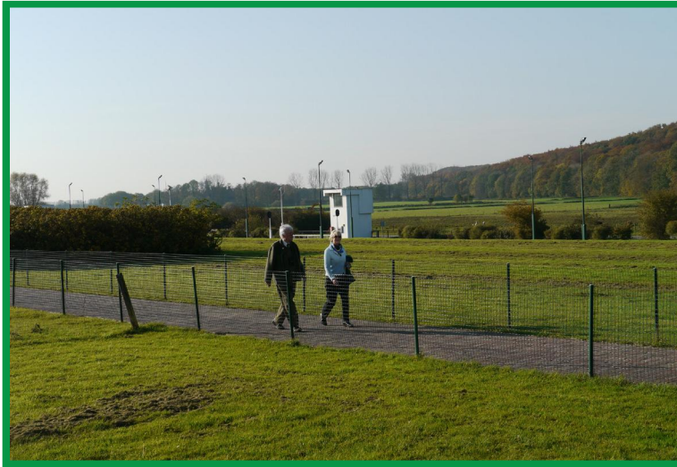
Een eenvoudig, onopvallend hek begrenst het openbare pad dat over het sluiscomplex loopt. RWS sluiscomplex Driel
