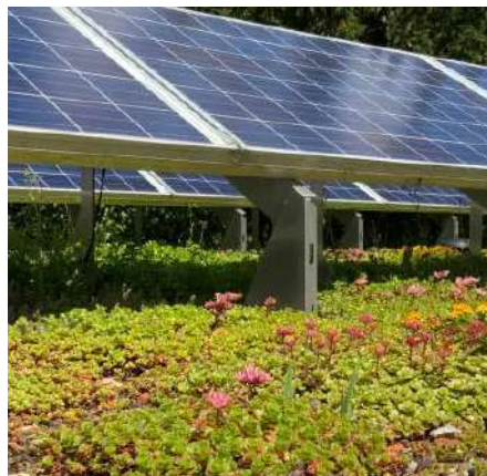
Zonnepanelen in combinatie met een groen dak
