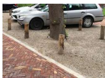
Parkeren op halfverharding
