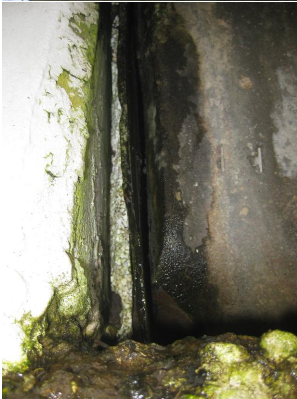
Asbestplaat tussen kop ligger en PS-schuim nog zichtbaar
