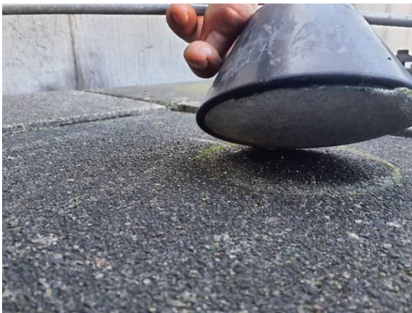
FB08: Het dak is in 2021 compleet vernieuwd. Er zijn geen asbestverdachte materialen waargenomen op het dak.
