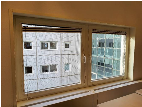
FB05: De kantelramen zijn in rubbers gezet.
