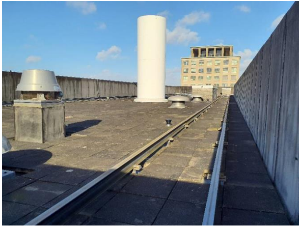
FB07: Het dak is in 2021 compleet vernieuwd. Er zijn geen asbestverdachte materialen waargenomen op het dak.
