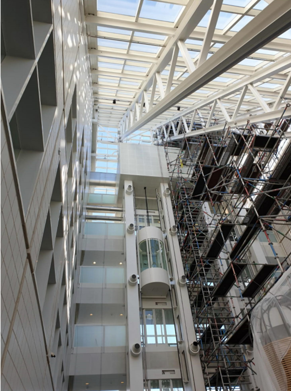
Figuur 2 voorbeeld binnensteiger Atrium
