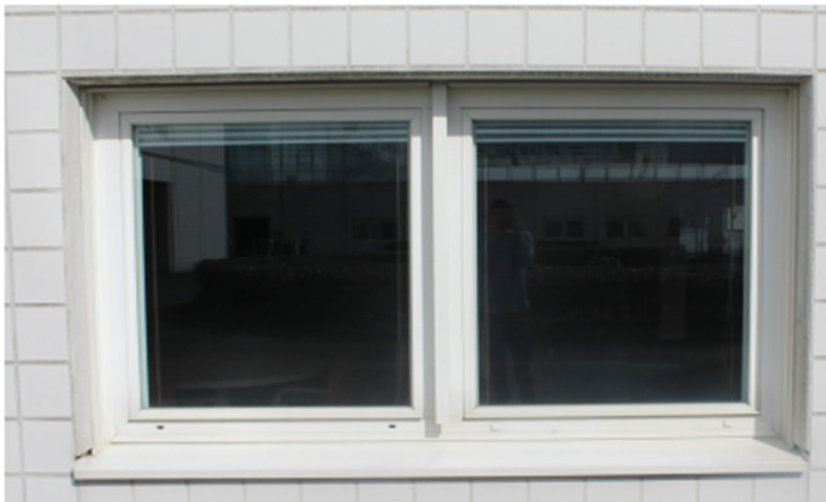
Foto van dubbel klampaam aan de binnenzijde
