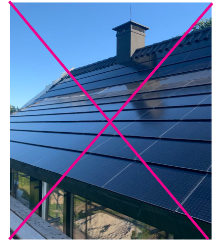
gehele dakbedekking van zonnepanelen
