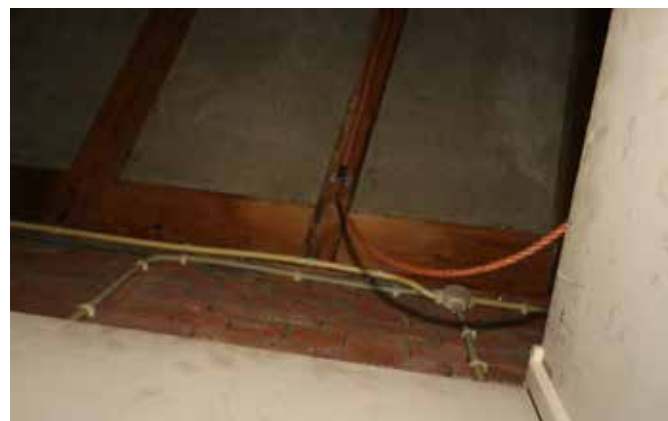
deel dak oude raadhuis met nieuw gemetselde borstwering
