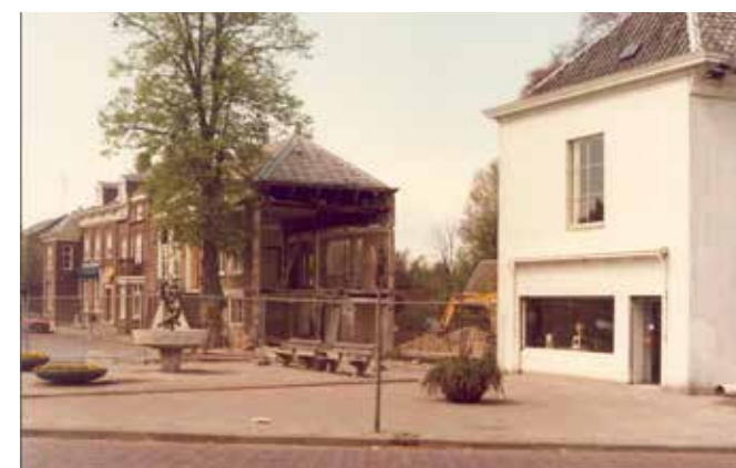
1982, sloop tbv nieuwbouw (foto BHIC FOTOSM.2065)
