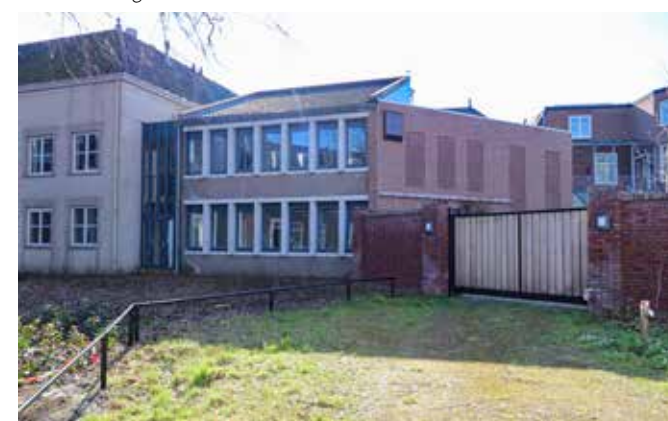
2022 achtergevel met rechts nieuwe gevel na gedeeltelijke sloop 2018
