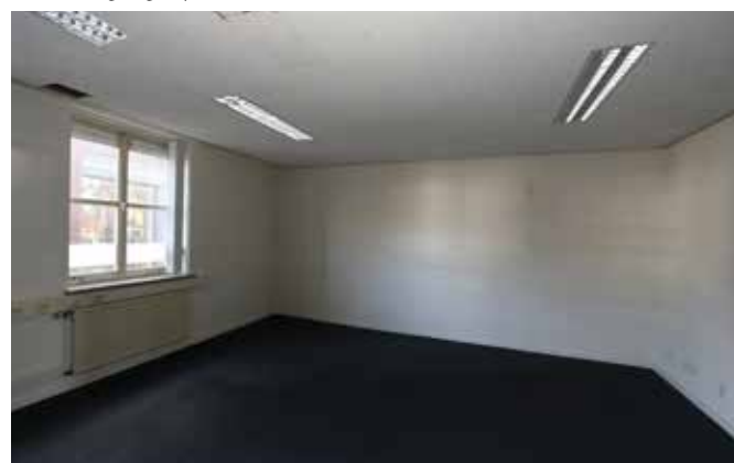
kantoorruimte bij de achtergevel in vml. huis Overkerk
