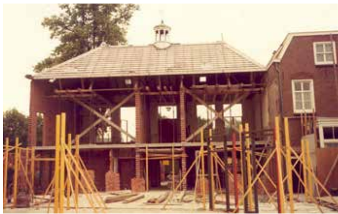
1982 nieuwe binnenmuren en betonnen vloer (BHIC FOTOSM.2093)
