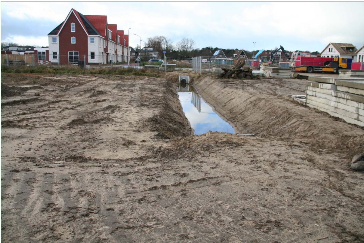
Deel van het terrein langs Creutzberglaan waar bouwwerkzaamheden plaatsvinden.
