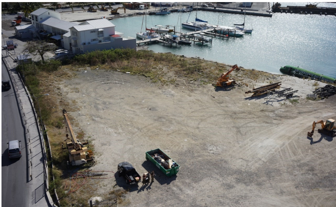
Overzicht situatie bij aankoop van het terrein in begin 2021. Enkele foto's ook beschikbaar in bijlagen.
