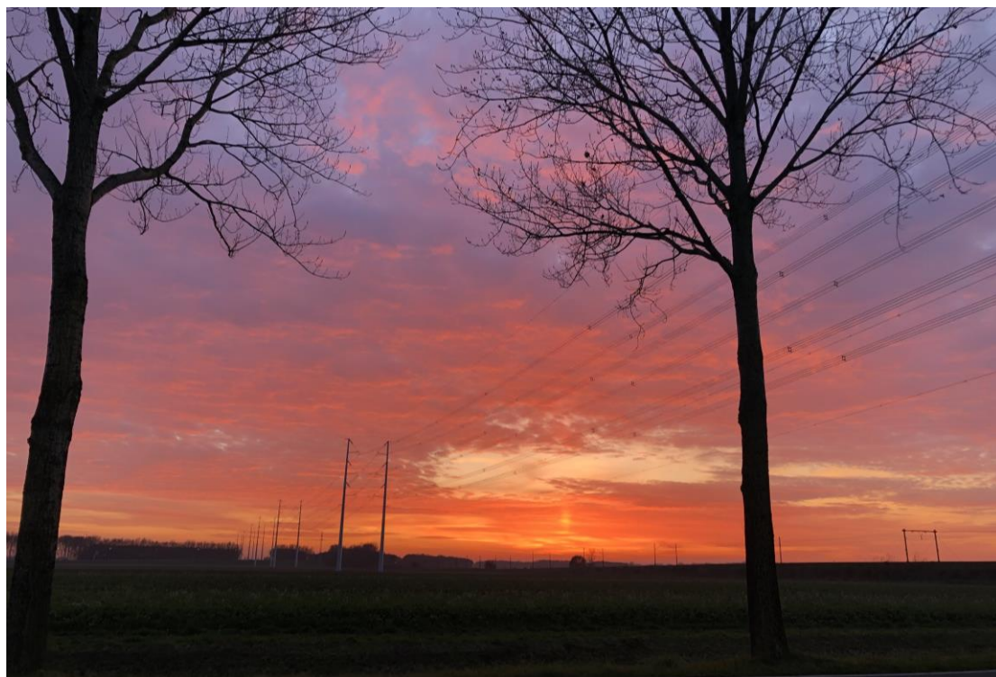
Figuur 3: Hoogspanningsmasten en spoor vanaf Lissersweg
