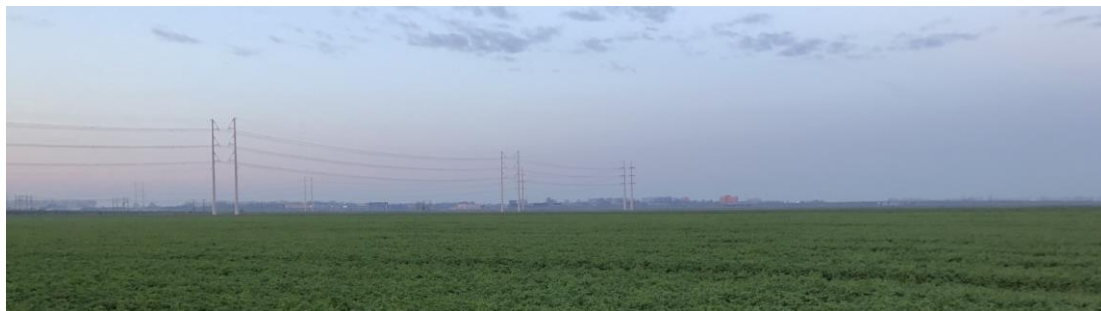
Figuur 1: Hoogspanningsmasten vanaf Lissersweg
