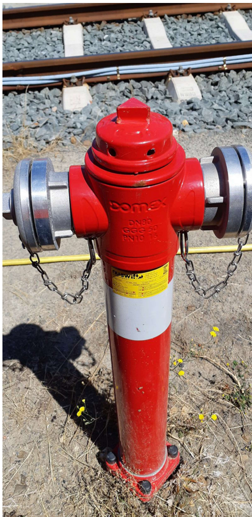
Figuur 6 Bovengrondse brandkraan/bluswaterafnamehydrant
