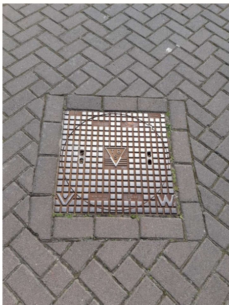
Figuur 13 Put vuilwater riolering
