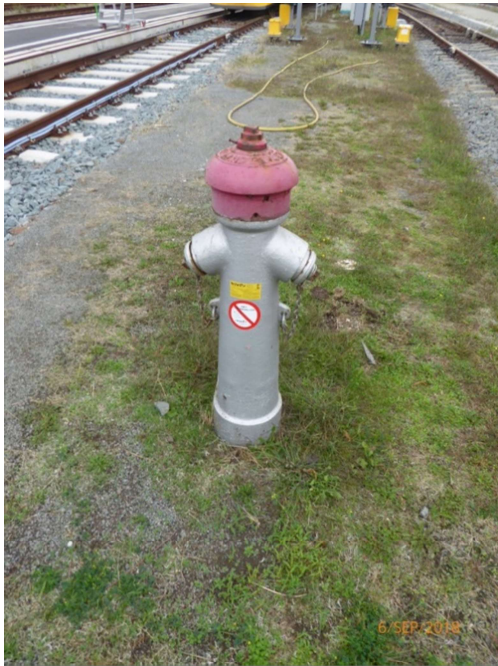
Figuur 5 Bovengrondse brandkraan/bluswaterafnamehydrant
