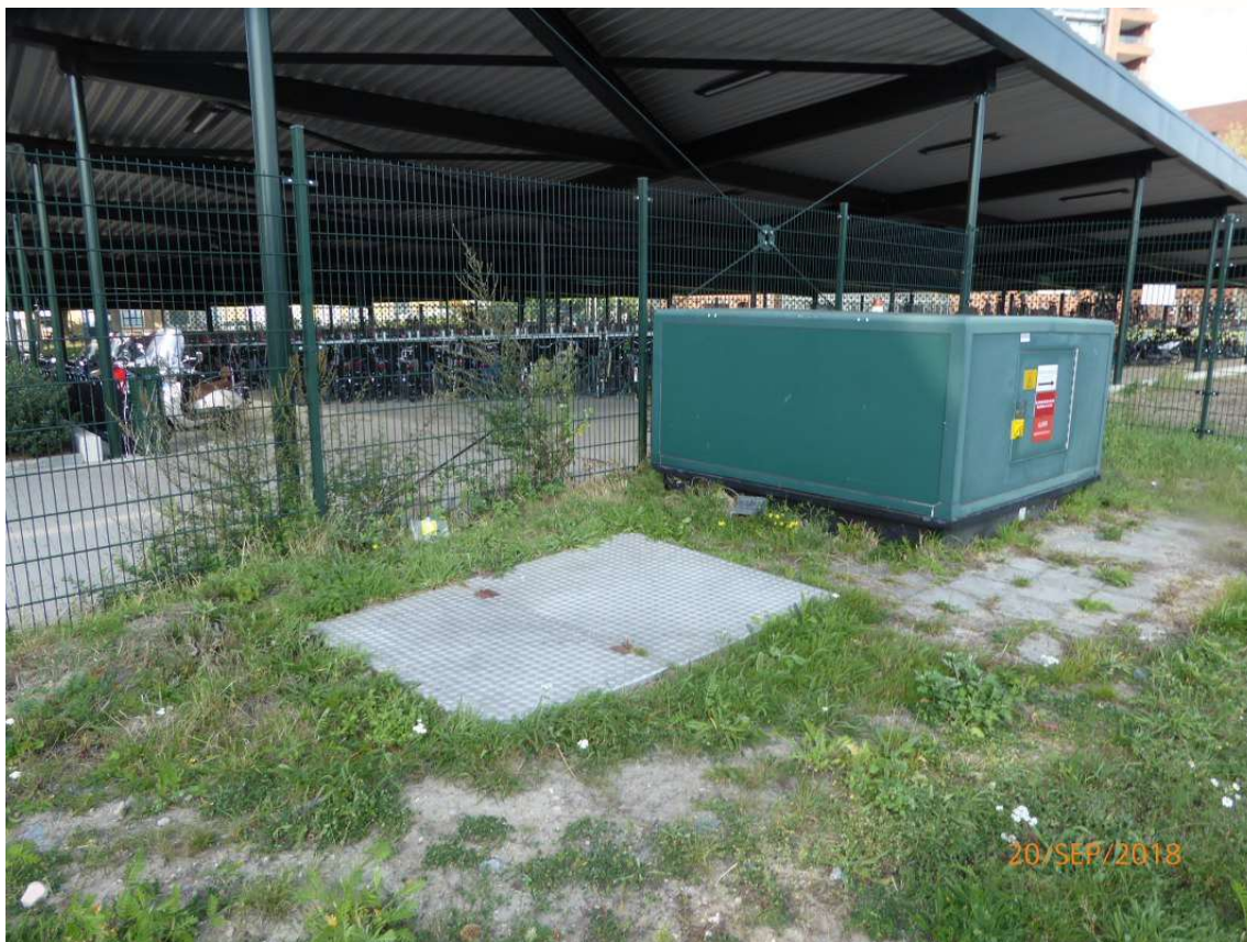
Figuur 23 Watermeterput naast break-unit
