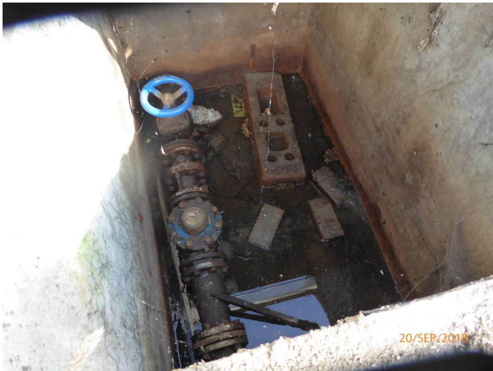
Figuur 24 Watermeter
