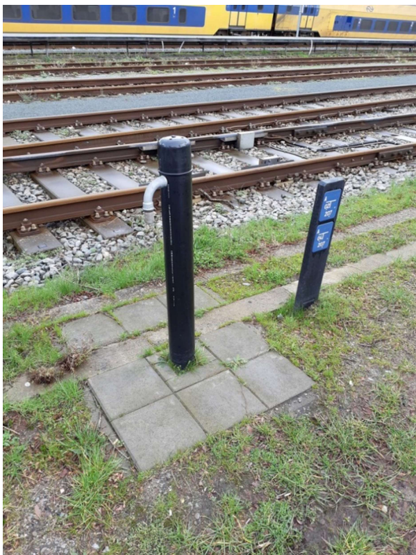
Figuur 18 Lekdetectie/Verklikkerinstallatie, uitvoering paal
