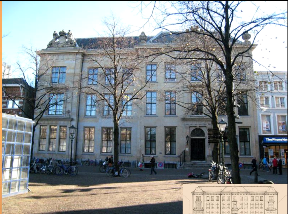
Foto gevel plein 4
