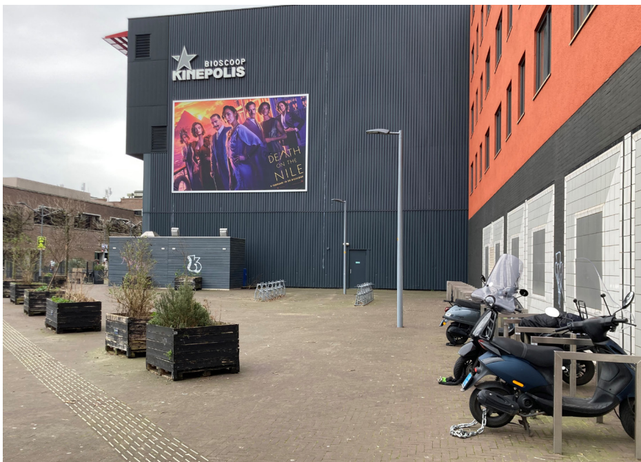
Hoek met ontluichtings- en toegangsgebouw tunnel, plantenbakken, fietsnietjes en rechts de steeg
