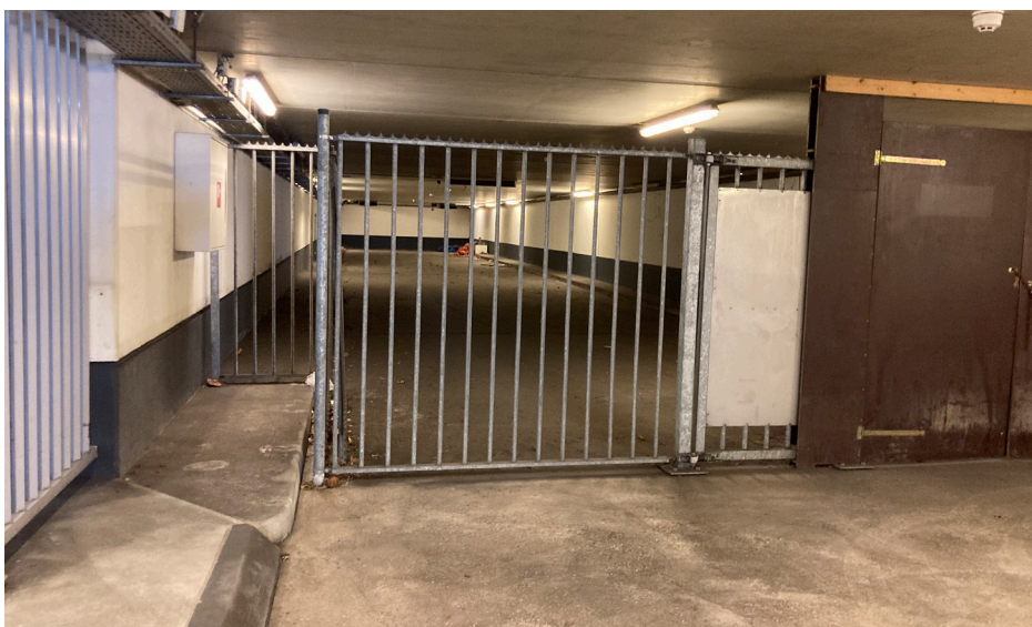
Steeg bij de bioscoop, met rechts de transformator
