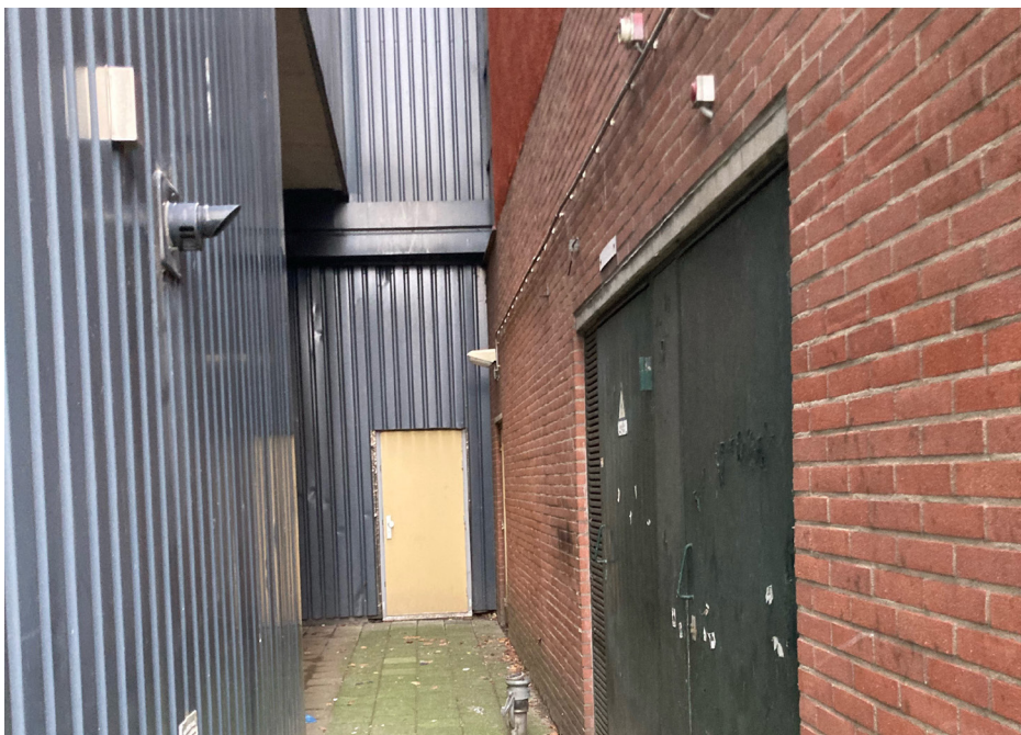
Steeg bij de bioscoop, met rechts de transformator
