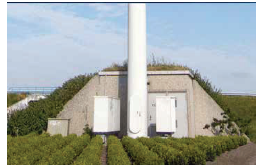
Regeltechniek van een windmolen in een talud verstopt, Walstroon in de haven van Dordrecht vormgegeven als bank
