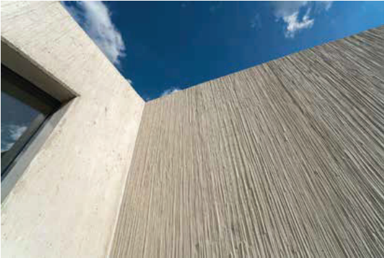
met rubber matten zijn vele variaties in textuur in beton relatief eenvoudig te realiseren, van afbeeldingen of tekst tot complete suggesties van andere materialen als riet, hout of baksteen
