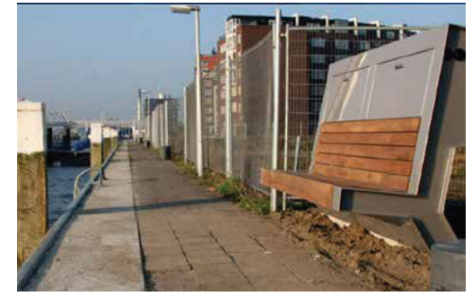
Regeltechniek van een windmolen in een talud verstopt, Walstroon in de haven van Dordrecht vormgegeven als bank
