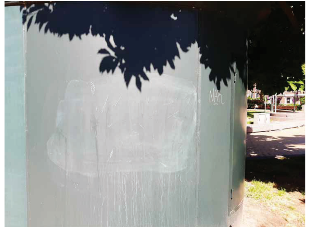
verwijderde graffiti op de gevel
