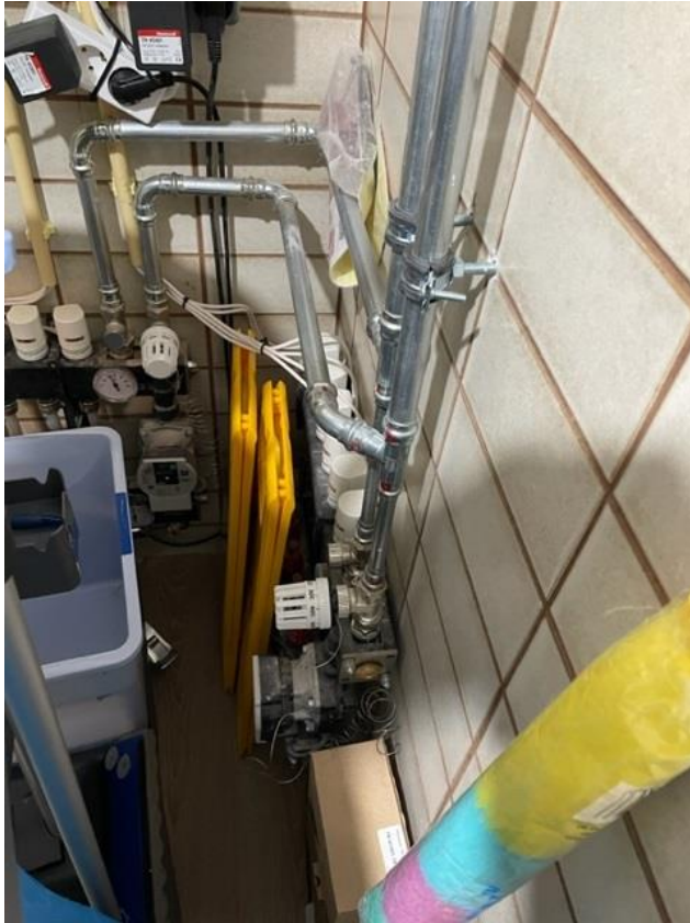
Gedeelte van Arabel is voorzien van vloerverwarming. Vorige ketel is hier apart voor. Zie verdeelstation.
