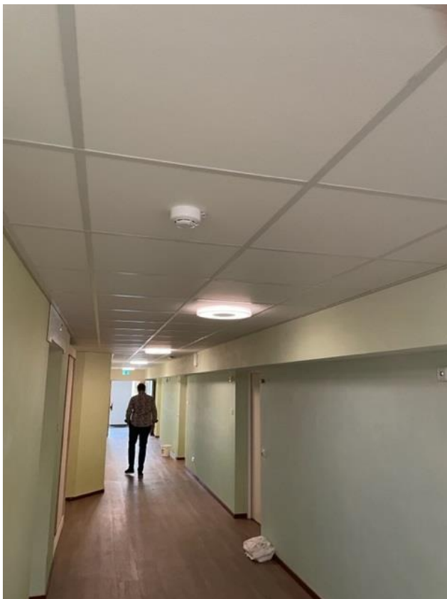
Nieuwe gedeelte Arabel is wel voorzien van sensoren en ledverlichting.
