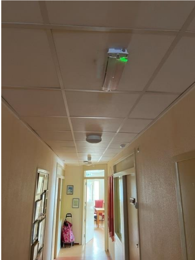
Bovenverdieping is niet verbouwd. Hier ook nog PL-lampen en tl-noodverlichting.
