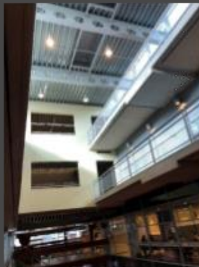
Dak constructie biedt mogelijkheden
