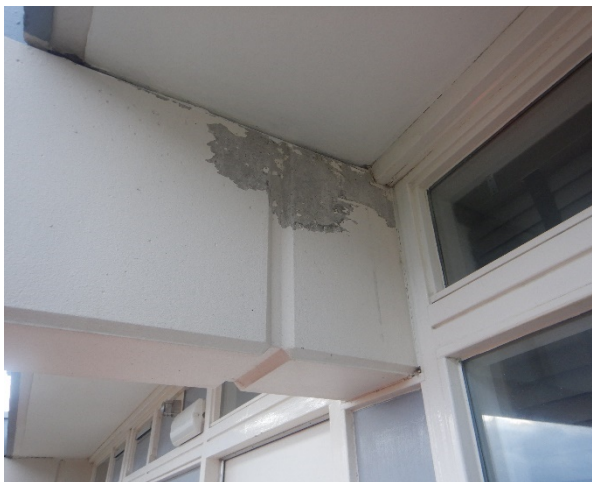
Figuur 6.14: Verwijderde coating voor onderhoudswerkzaamheden
