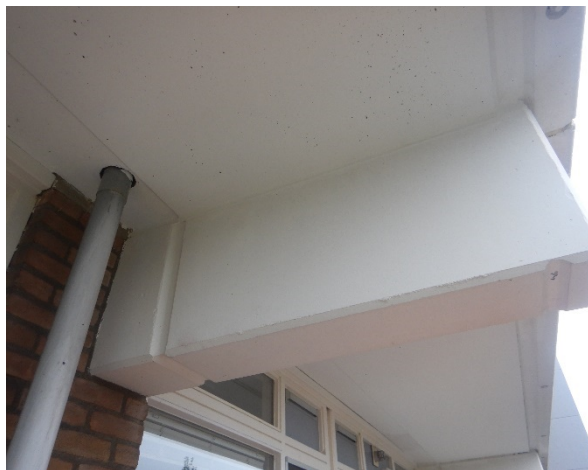
Figuur 4.2: Consoles onder de galerijvloer
