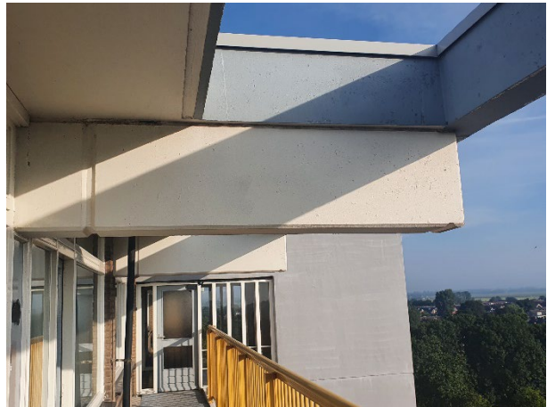
Figuur 2.2: Overzicht galerij met consoles.
