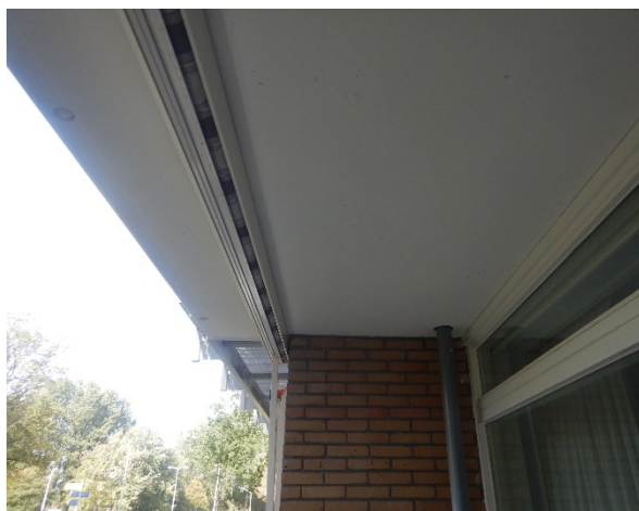
Figuur 4.4: overzicht bovengelegen balkonvloer
