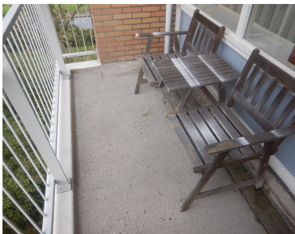
Figuur 4.3: Overzicht balkonvloer
