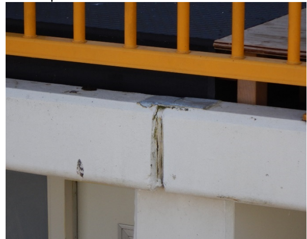
Figuur 6.10: Kitvoeg oogt verouderd en is losgescheurd
