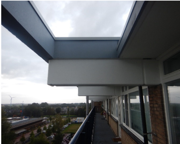
Figuur 6.12: Console dakvloer
