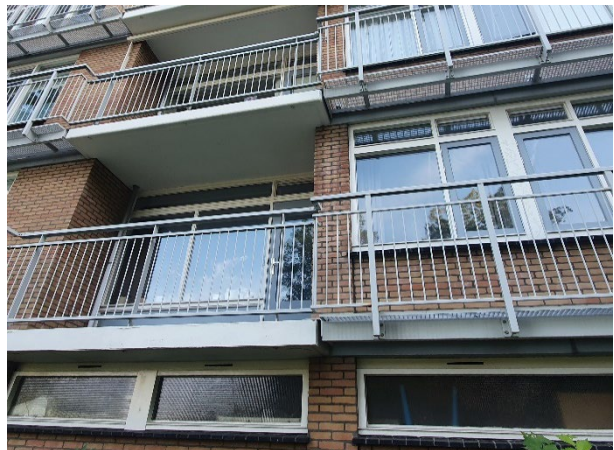
Figuur 2.4: Onderaanzicht betonnen balkonplaten.
