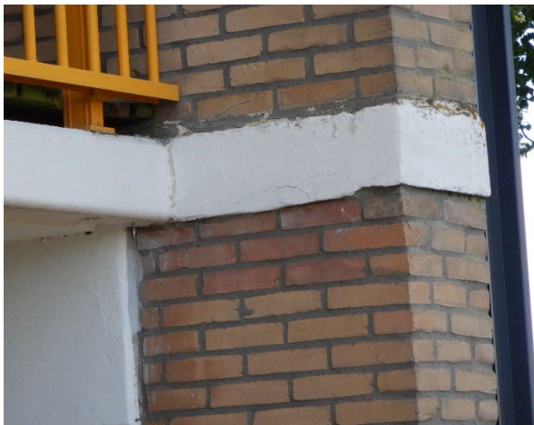
Figuur 6.11: Losgescheurd beton(reparatie)
