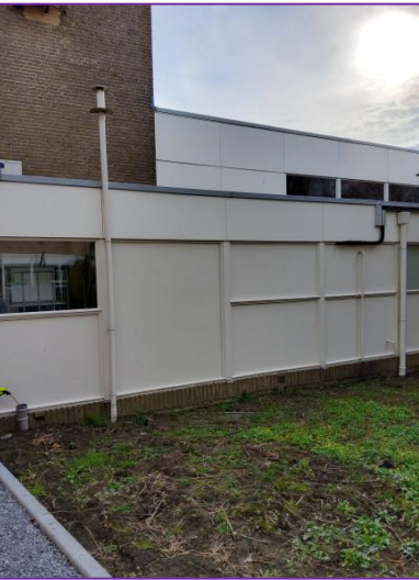
Impressie bestaande situatie
