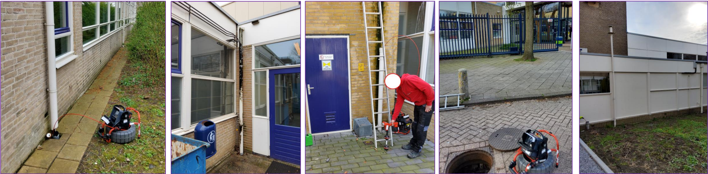
Impressie bestaande situatie
