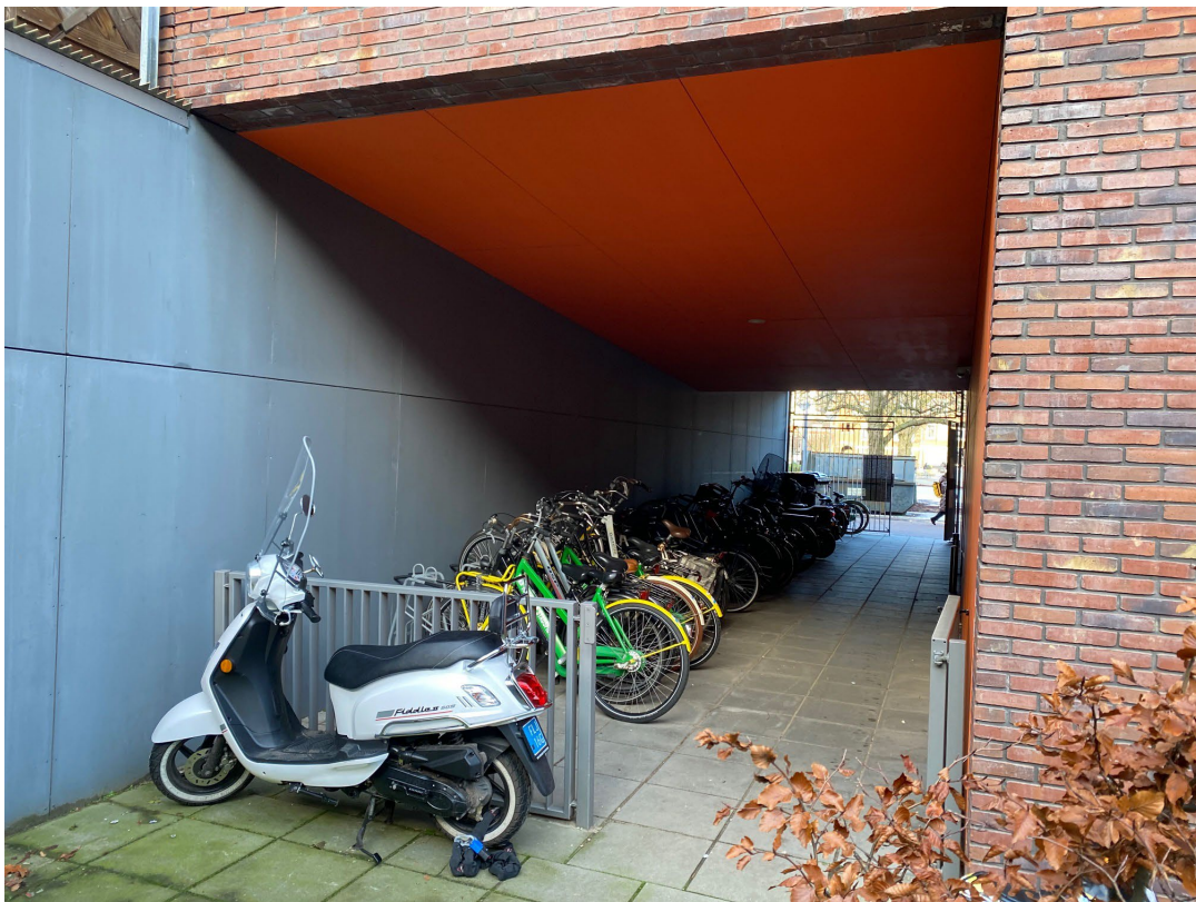
4: 5: Onderdoorgang vanaf achterzijde
