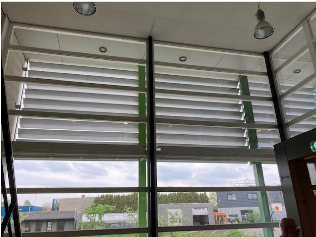
EA schoonmaak GSG 2022 - Foto's locatie Groningen - Lavendelweg
