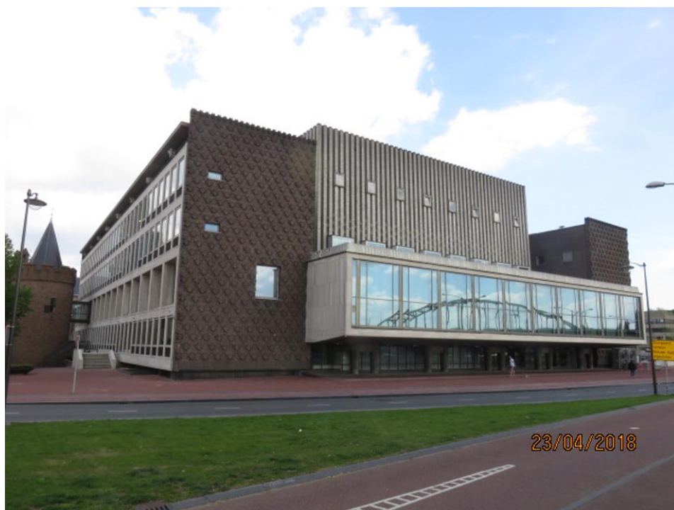
Aanzicht bestaande deel
