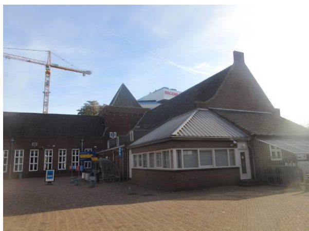
Aanzicht gebouw E
