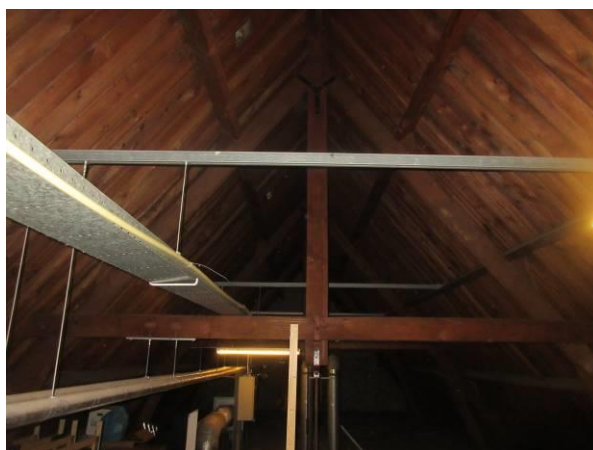
Dakconstructie gebouw E
