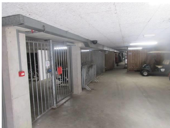
Gebouw A, fietsenkelder
