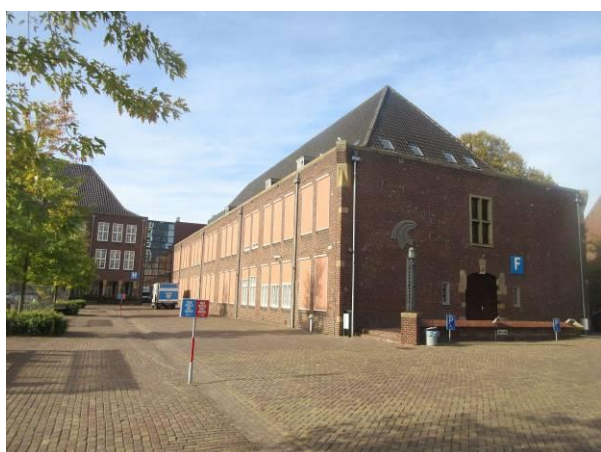
Aanzicht gebouw B en F
