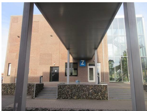
Gebouw Z met corridor naar gebouw A
