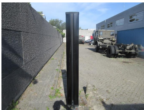
Infraroodbeams op buitenterrein
