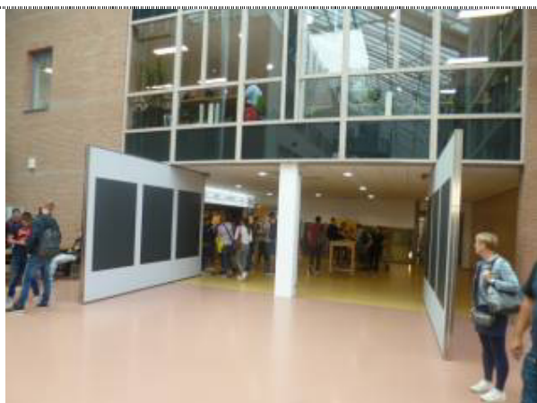
Foto 11: brandwerende scheiding. Op de achtergrond de kantine
