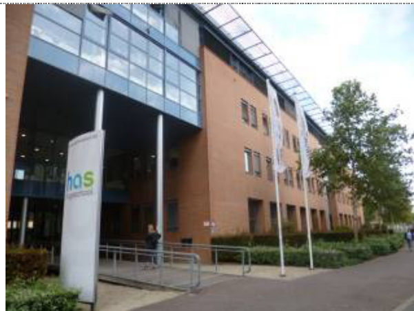
Foto 1: deel van de voorgevel
