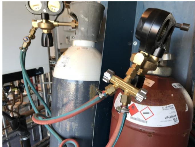
Ontbreken van een vlamdover
