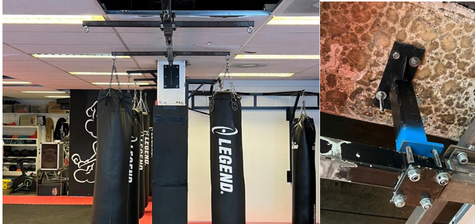
Huidige stalen frame ten behoeve van bokszakken in Sportschool Westerkoog
