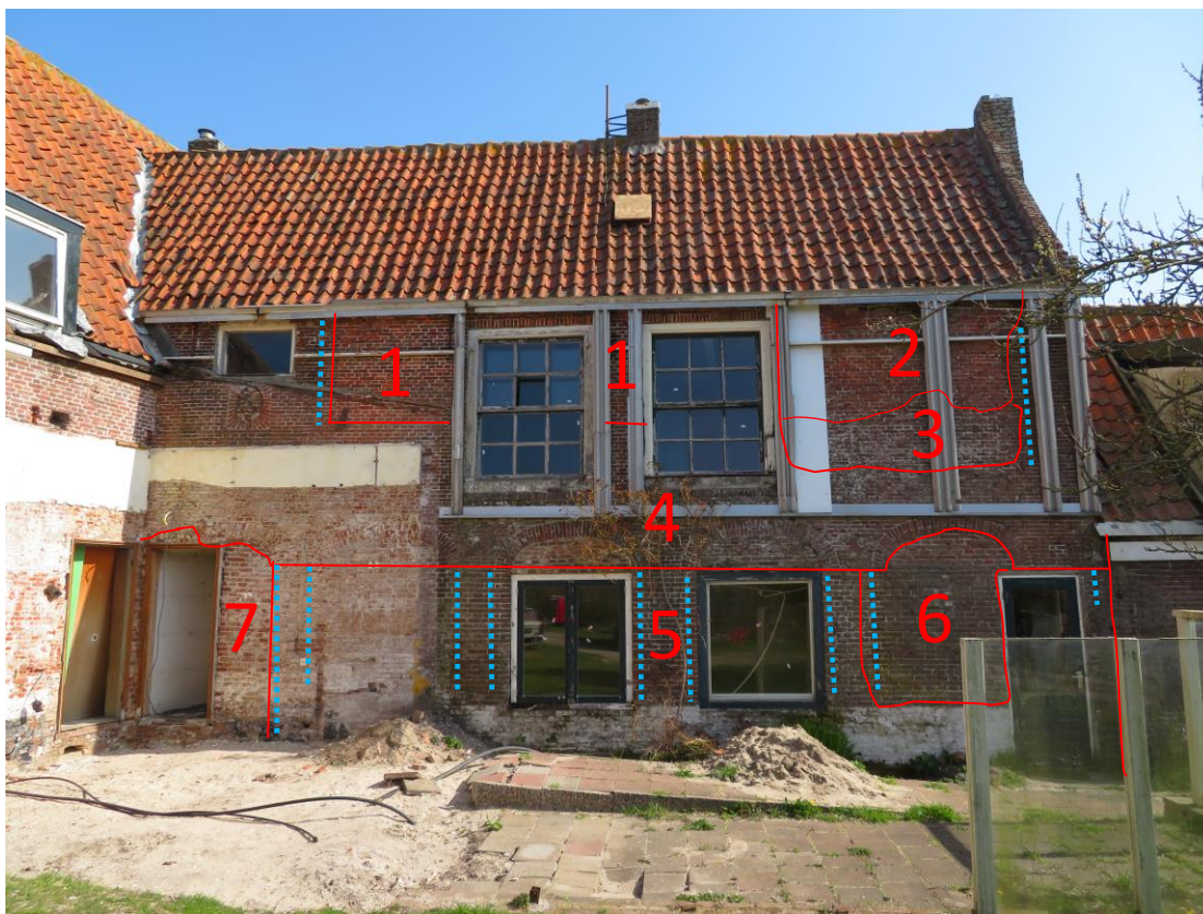
Zuidwestgevel 44-Z1; in rood de verschillende velden metselwerk, in blauw de klisklezoenen.
