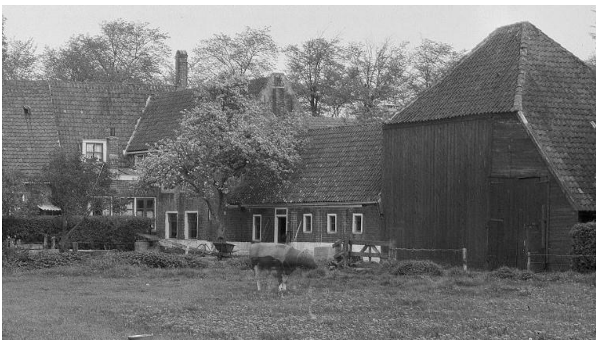
Het erf met de achterzijde van Slotweg 44 in 1937. Links is een aanbouw aan de achterzijde van Slotweg 44 te zien, die mede op basis van de roedenverdeling van de ramen op de tweede helft van de 19 e eeuw te dateren is. In het midden is het huidige bouwdeel 44-Z2 te zien, rechts het hooihuis. (collectie Stichting Historisch Egmond)
