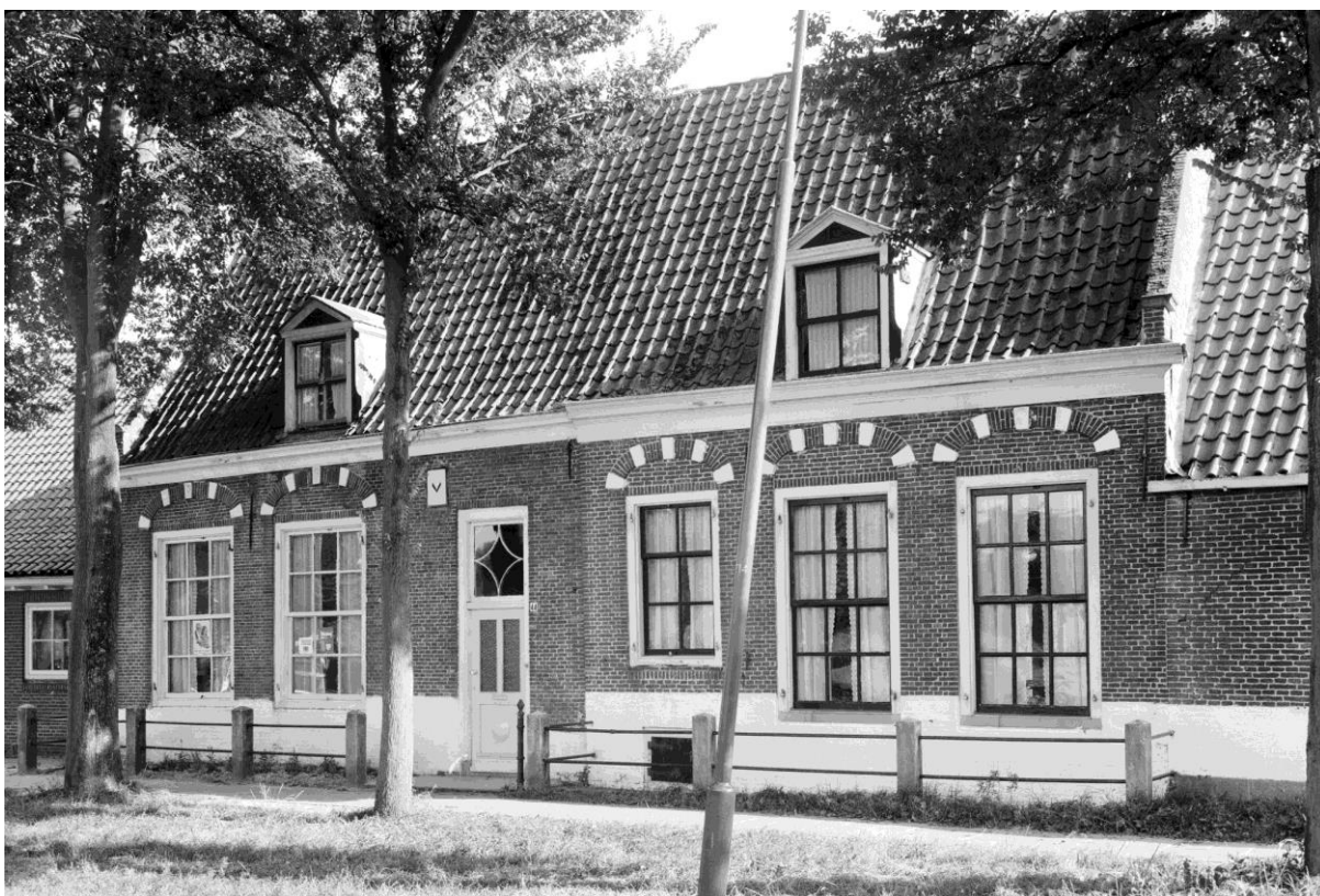
De voorgevel in 1964; het houtwerk is witgeschilderd en de luiken zijn verwijderd. (collectie RCE)
