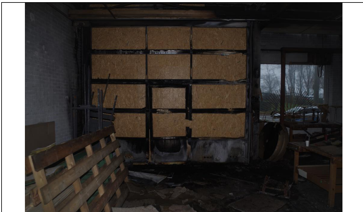
Foto 3: opname van de overheaddeur. De opname is gemaakt vanuit het gebouw.
