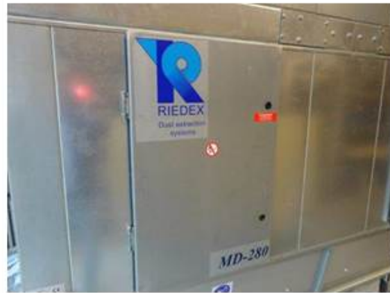
Foto 8 Filterkast houtmotafzuiging met blussing
