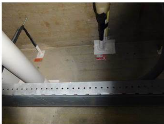
Foto 3 Brandwerend afgedichte doorvoeren
