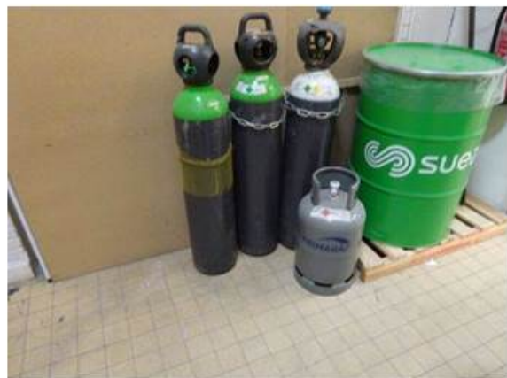
Foto 6 Losse gasfles
