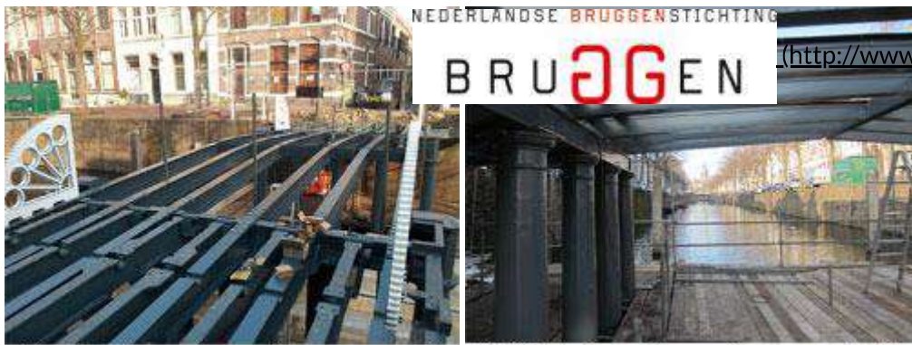
Afb. 7. De nieuwe liggers zijn van constructie staal model conform de originele tekeningen
