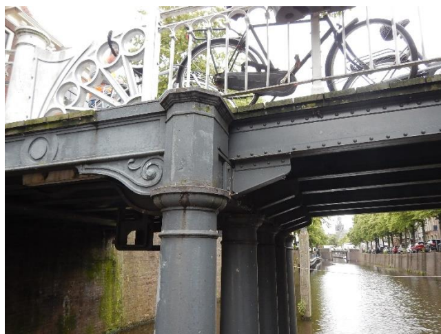
Afbeelding 7: Overgang tussen zij- en middenoverspanning
