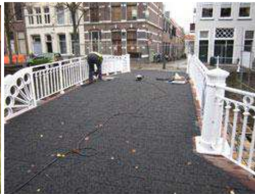
Afb. 10. Montage van het houten dek (Azobé)
