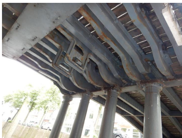
Afbeelding 5: Onderaanzicht zijoverspanning bij tussensteunpunt
