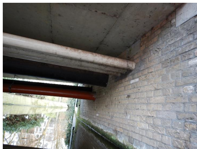
Afbeelding 7: Onderzijde dek en landhoofd west
