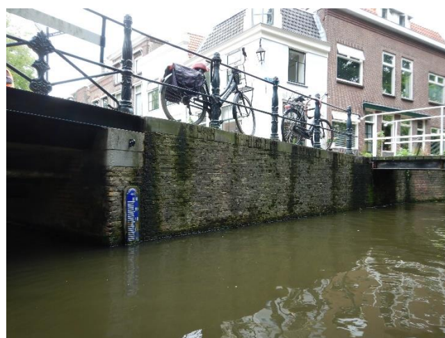
Afbeelding 5: Aanzicht vleugelwand zuidoost (Vijverstraat(brug))
