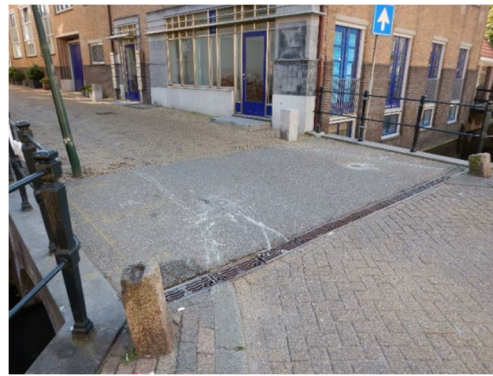
Foto 2: Rijvloer en draingoot gezien vanuit het westen.
