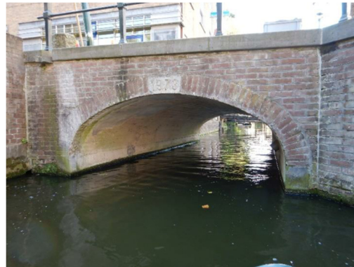
Foto 4: Noordelijk zijaanzicht / onderzijde dek.
