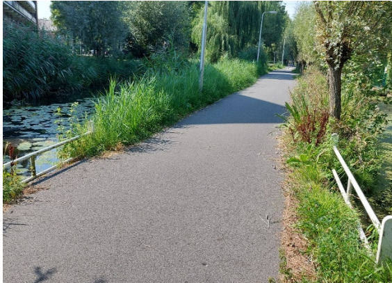
Foto 40: Situatie op brug in westelijke richting gezien.
