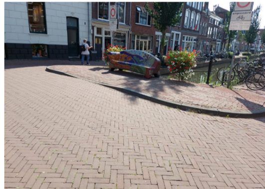
Foto 30: Situatie op brug t.p.v. de westzijde.
