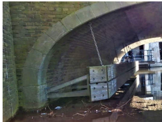
Foto 12: Toeg met metselwerkbekleding en aanvaarconstructie.
