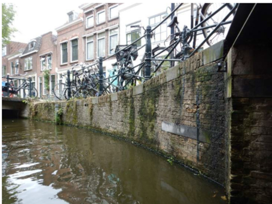
Foto 15: Aanzicht vleugelwand noordoost (Spieringsstraat).
