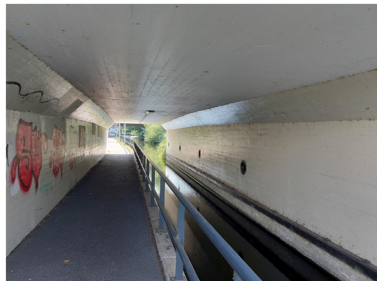
Foto 37: Situatie in tunnel vanuit het noorden gezien.
