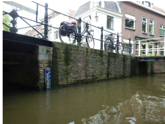
Foto 16: Aanzicht vleugelwand zuidoost (Vijverstraat(brug)).
