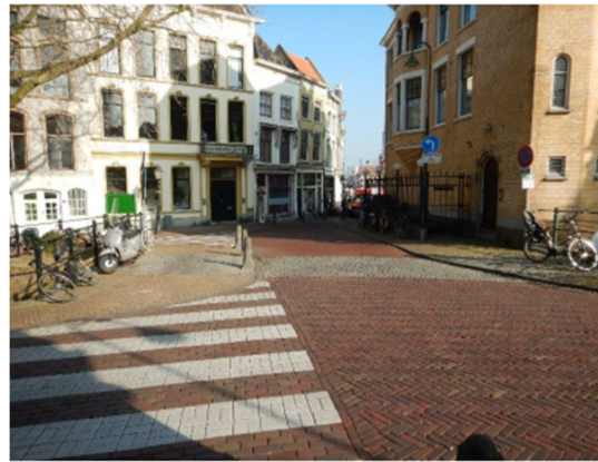
Foto 10: Rijvloer gezien vanuit het zuiden.
