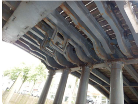
Foto 22: Onderaanzicht zijoverspanning bij tussensteunpunt.
