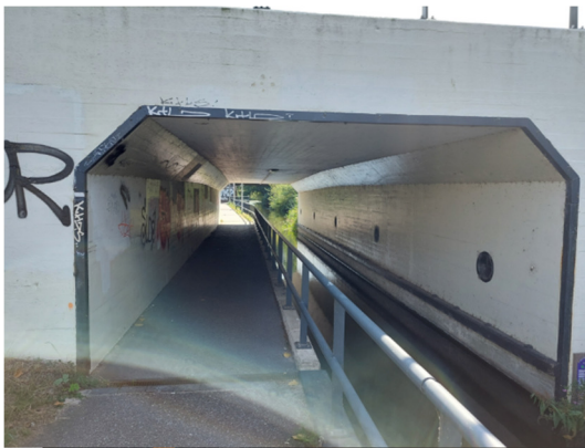
Foto 36: Situatie in tunnel vanuit het noorden gezien.
