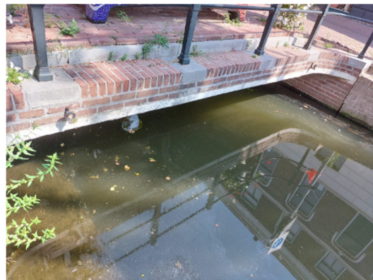
Foto 26: Westelijke dekrand met zichtbaar sloven net onder de waterlijn.
