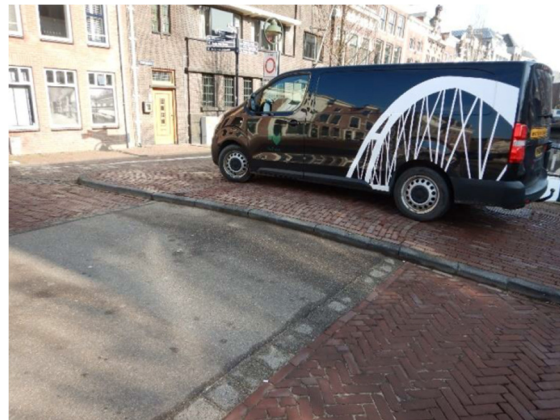
Foto 8: Situatie oostzijde brugdek met putdeksels t.b.v. duiker.
