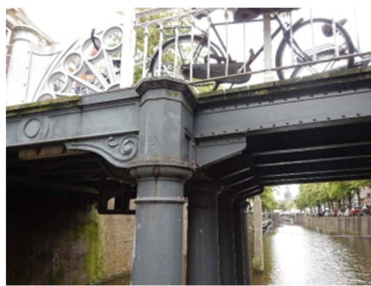
Foto 24: Overgang tussen zij- en middenoverspanning.
