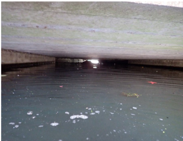
Foto 31: Onderzijde westelijke uitbreiding uit 1962.
