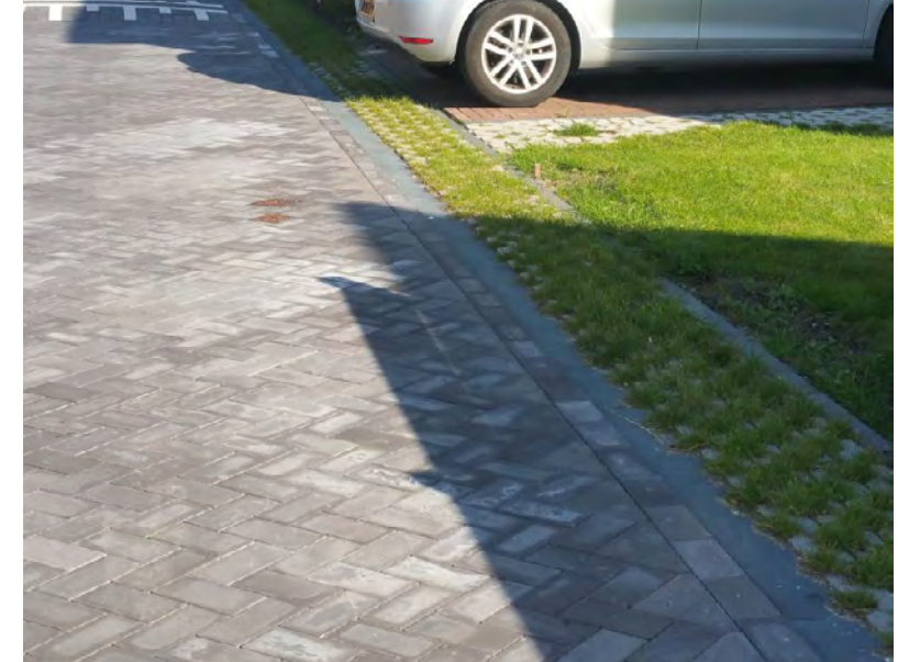
Randen van grasbeton beperken de hoeveelheid verharding
