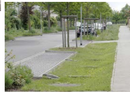
Drie manieren om hemelwater op te vangen in de straat: boven met openbaar groen, hiernaast met een betonnen goot en onder met een wadi langs het parkeren
