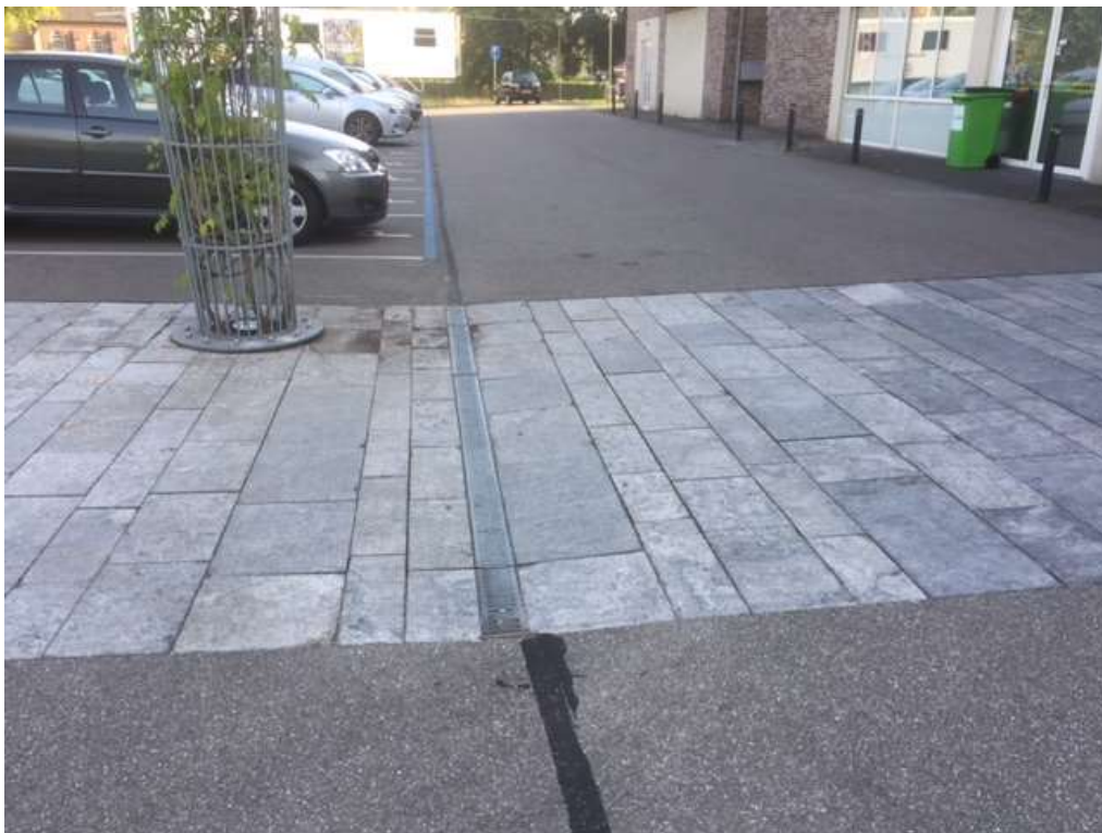
Voorbeeld “Lijngoot”; reinigen per meter conform 220010 (Locatie parkeerterrein Houtlaan te Groesbeek)
