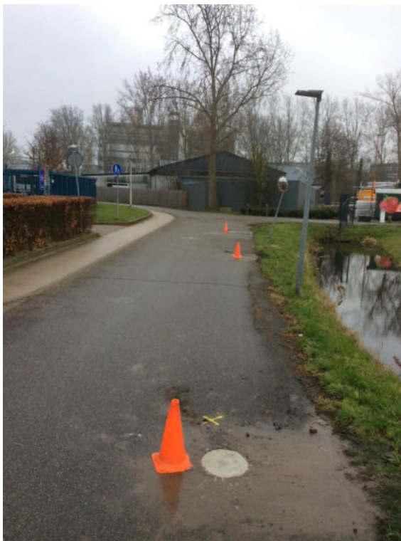
Afwerking inspectiegaten
