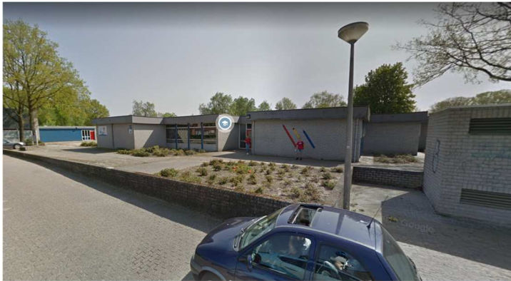
Afbeelding: locatie Mantingerbrink 203 met hoogteverschillen en bestaand trafohuisje (onderste afbeelding rechts)
