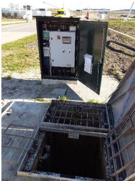
Figuur 28: Voorbeeld opstelling gemaal
