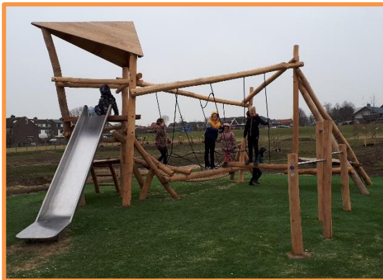
Noorden, DrieKoppenland in aanleg
