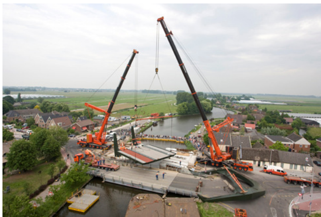
Bouw nieuwe brug Vrouwenakker (2008)
