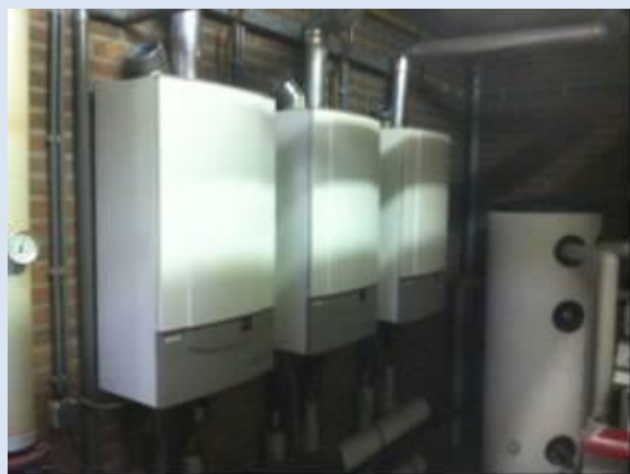
Figuur 2.1 Foto's gebouw
