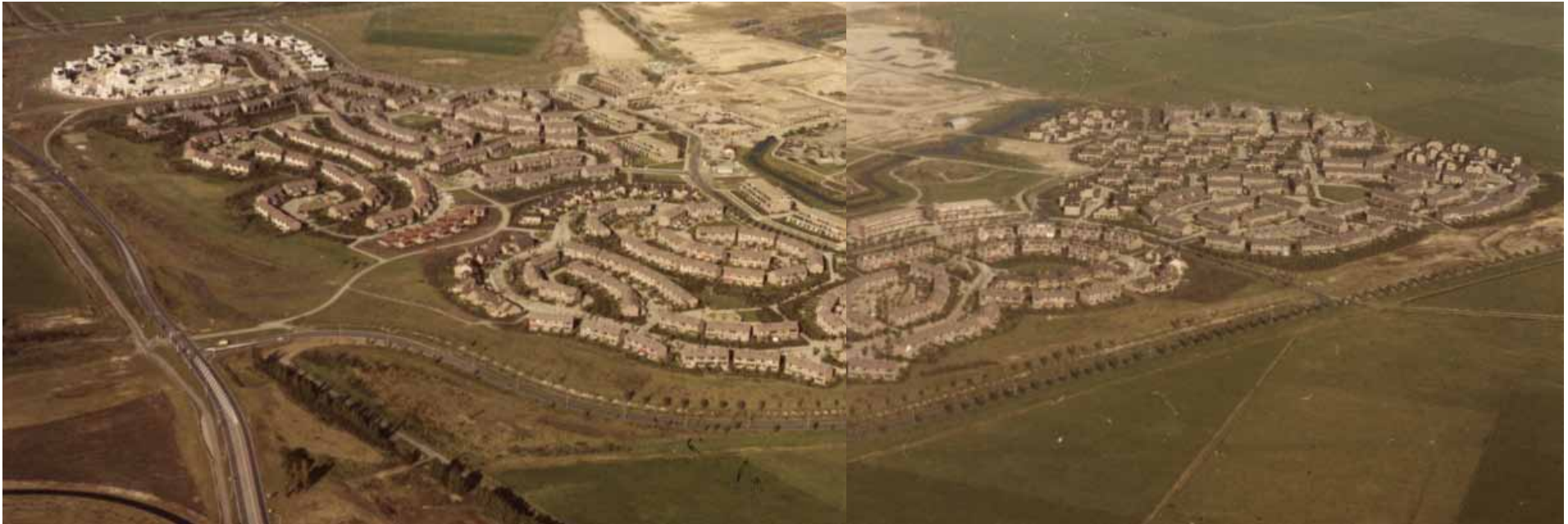
De Bijvanck in aanbouw [bron: Historische Kring Blaricum]
