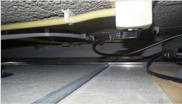
Ruimte boven systeemplafond.
