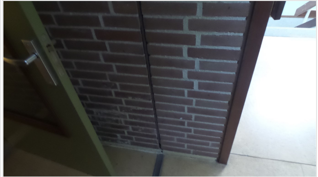
Dilatatie in gang niet asbestverdacht.
